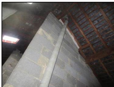
Photo N° 883 AMIANTE CIMENT -- COMBLES Gaines & coffres verticaux Ventilation haute (Fibres- ciment)
